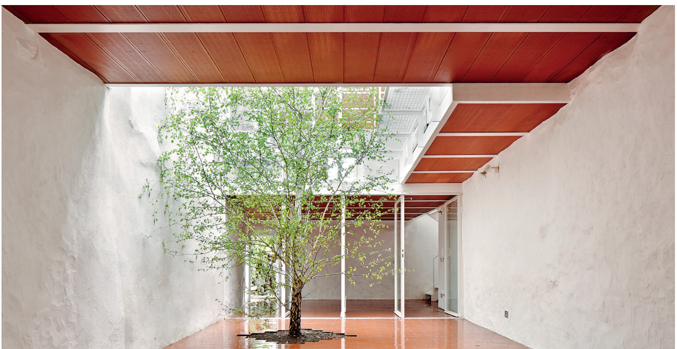
Figura 3. Instalación de tablero sobre vigueta metálica
