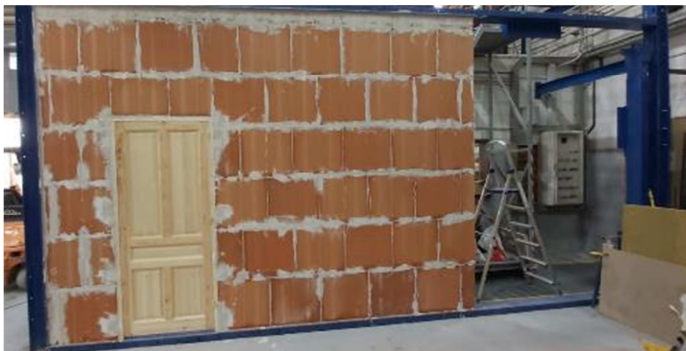
Proceso de ejecución la pared MURALIT ensayada. Fábrica de ladrillo hueco gran formato sin revestir con una configuración de acuerdo con lo establecido en la norma
