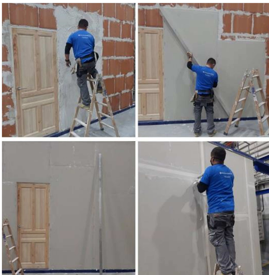
Proceso de ejecución la pared MURALIT ensayada. Aplicación del revestimiento de placa de yeso sobre la fábrica de ladrillo hueco gran formato
