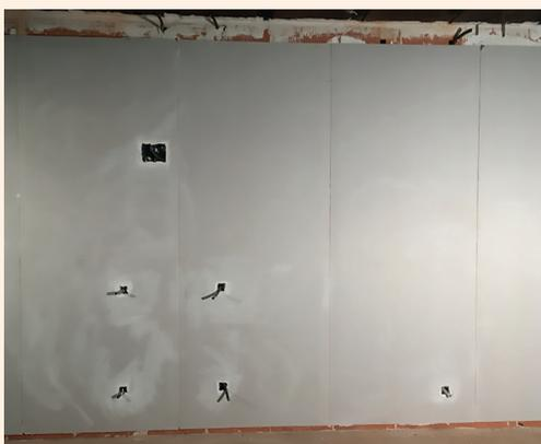
**Figura 6.-** Imágenes de ejecución de un tabique MURALIT Sin Rozas incorporando los tubos y cajas para las instalaciones de electricidad (cajas de registro, interruptores y enchufes).
