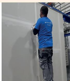
**Figura 5.-** Puesta en obra del revestimiento de placa de yeso laminado.
