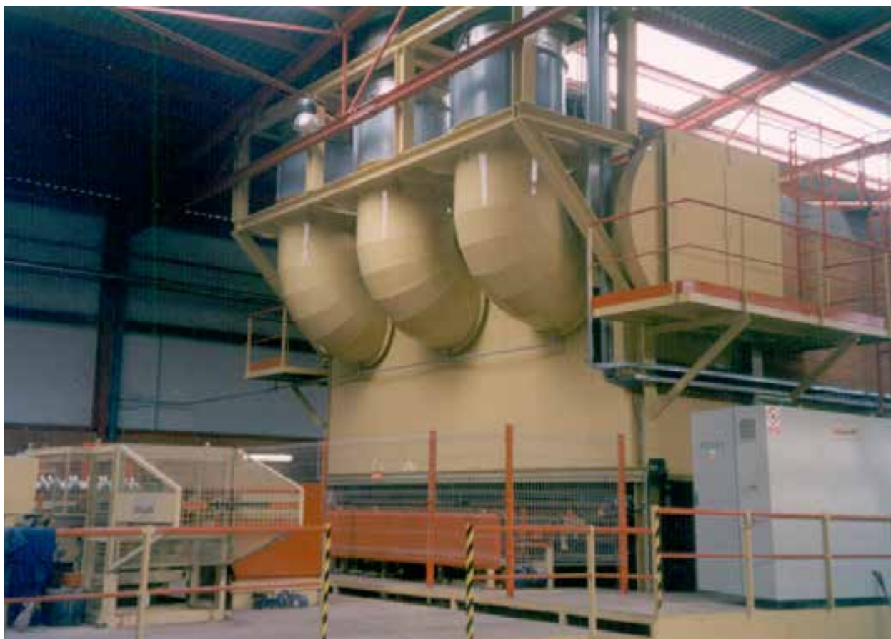
FRONT DRYER FANS | VENTILADORES ANTERIORES DEL SECADERO VENTILATEURS ANTÉRIEURS DU SECHOIR
