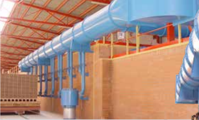
HAND-REGULATED AIR EXHAUST REGULACIÓN MANUAL DE EXTRACCIÓN DE AIRE RÉGULATION MANUELLE DE L'EXTRACTION D'AIR
