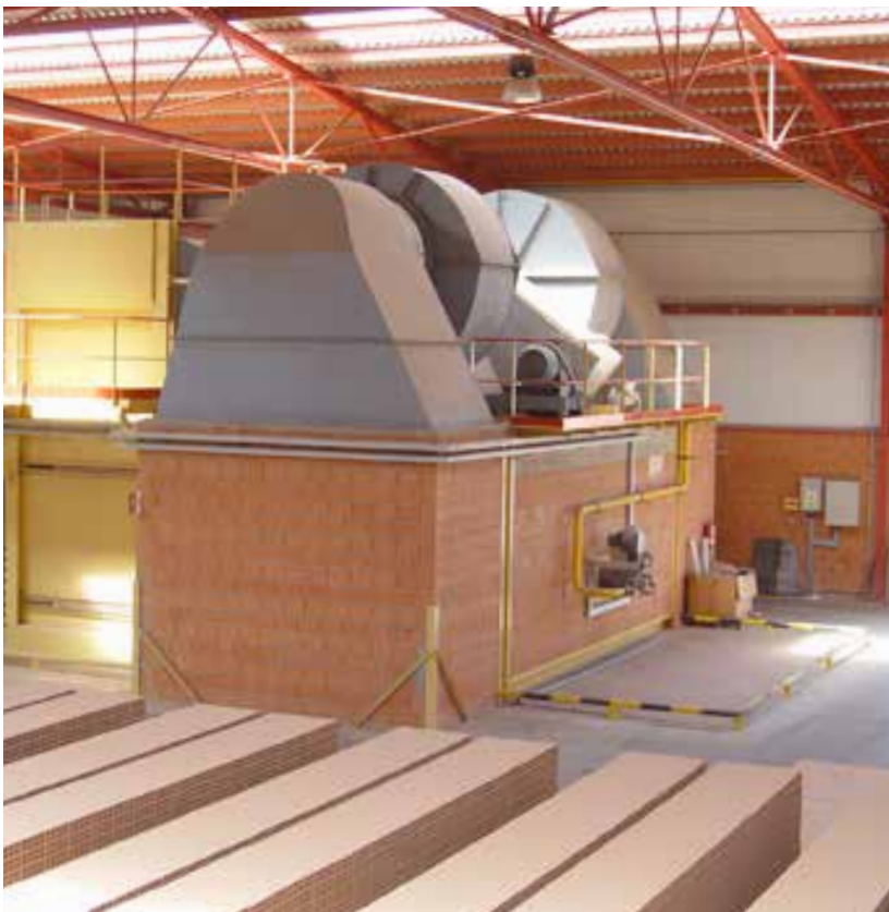
DRYER REAR AIR-RECIRCULATION FANS | VENTILADORES POSTERIORES DE RECIRCULACIÓN DEL SECADERO VENTILATEURS DE BRASSAGE ARRIÈRE SÉCHOIR
