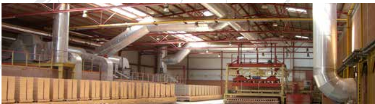
WASTE HEAT RECOVERY DUCTS | CONDUCTOS DE RECUPERACIÓN | CONDUITES DE RÉCUPÉRATION
