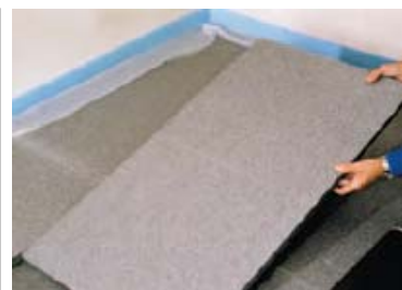
Detalle colocación de paneles
