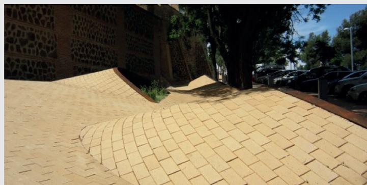
Figura 9 Obra con adoquín cerámico
