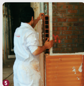
5 Muntatge d'una cantonada amb les peces alternades.
