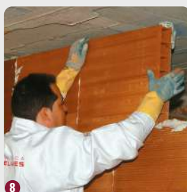
8 Acabat i coronament contra el sostre (cinquena filada).
