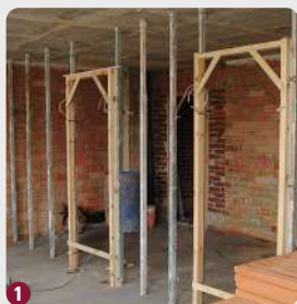
1 Muntatge de premarcs i regles telescòpiques.
