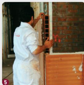
5 Montaje de una esquina con las piezas alternadas.
